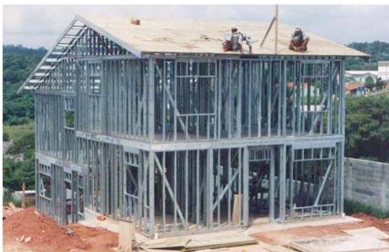
Figura 3 – Construção residencial em Light Steel frame
