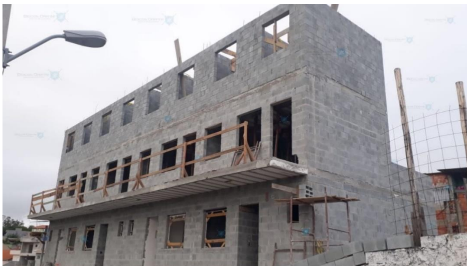
Figura 2 – Edificação em Alvenaria Estrutural
