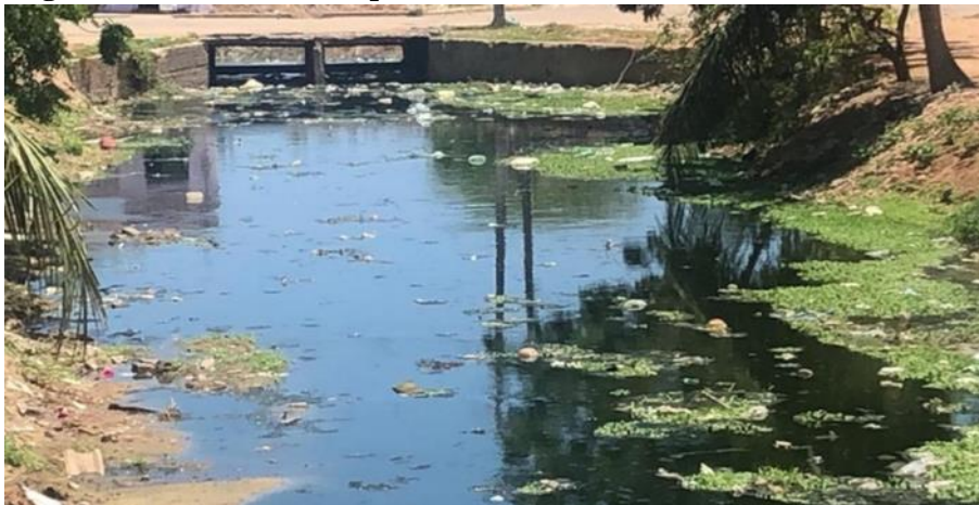
Figura 3 – Descarte inadequado de lixo
